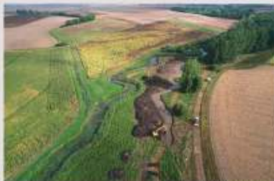
Travaux en cours - Restauration morphologique et création d'une zone tampon - Averdon (41)
